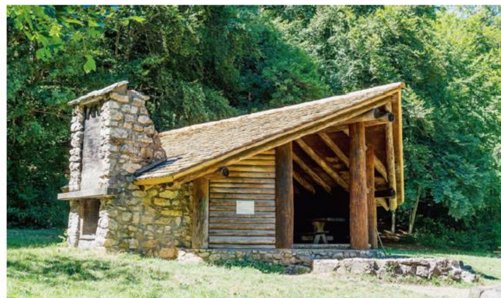
Construit avec un toit en bardeaux et du bois de la région, l'abri avait été inauguré en 1986. LUCAS VUITEL
